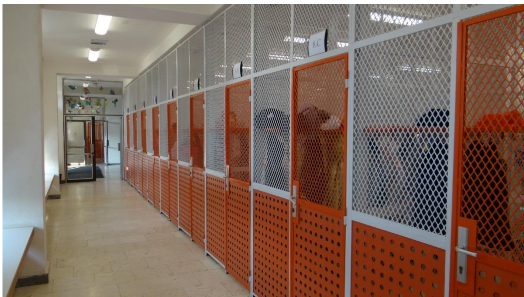
V tomto roce se podařila náročná oprava žákovských šaten
